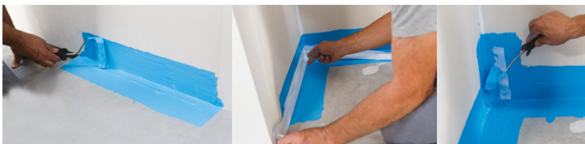
Protection des pieds de cloison avec le SPEC Knauf Étanche :
