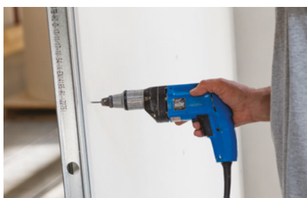
Vissage des plaques Knauf HydroProof®
