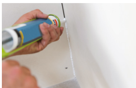
Traitement des cueillies, des angles rentrants et des points singuliers à l'aide d'un mastic sanitaire label SNJF
